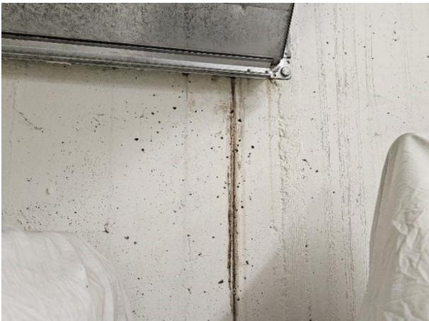
Figure 77 : Traces de ruissellement le long du mur « ouest » sous le conduit d'aération © He-Arc, Axel Guisolan, 2024.
