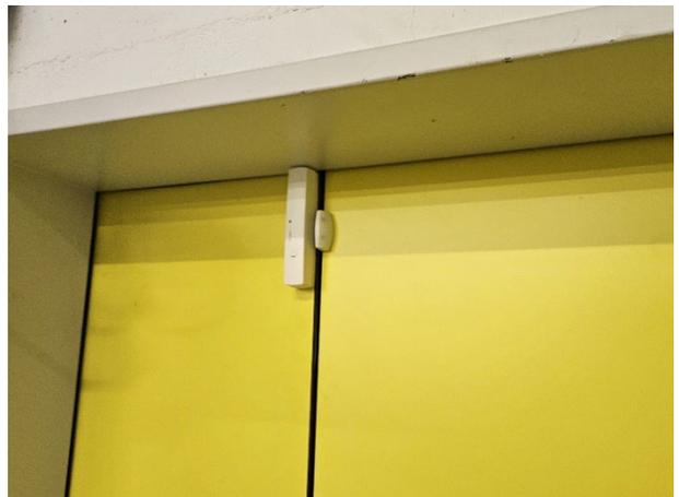
Figure 54 : Réserve de Ste-Claire, système de détection d'ouverture de porte © He-Arc, Axel Guisolan, 2024.
