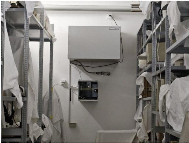
Figure 105 : Réserve de Ste-Claire, déshumidificateur fixé au mur © He-Arc, Axel Guisolan, 2024.
