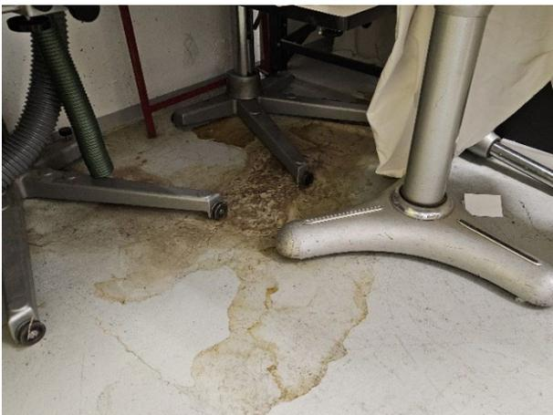
Figure 79 : Traces laissées par l'eau une fois sèche © He-Arc, Axel Guisolan, 2024.
