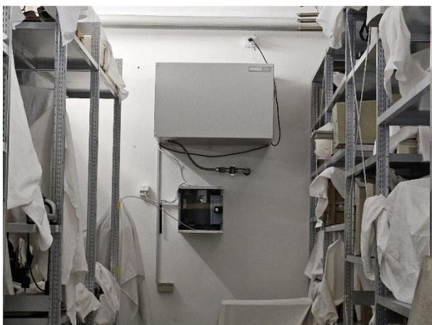
Figure 55 : Réserve de Ste-Claire, déshumidificateur fixé au mur "est" © He-Arc, Axel Guisolan, 2024.
